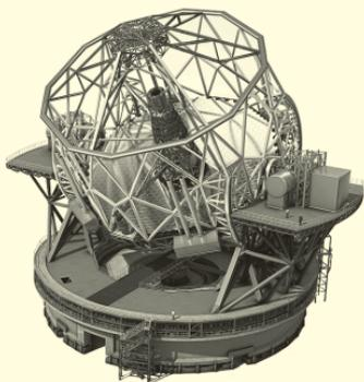
Чрезвычайно большой телескоп (Extremely Large Telescope, ELT) — строящаяся астрономическая обсерватория, главным инструментом которой станет телескоп с сегментным зеркалом диаметром в 39,3 м, состоящим из 798 шестиугольных сегментов диаметром 1,4 метра каждый.
